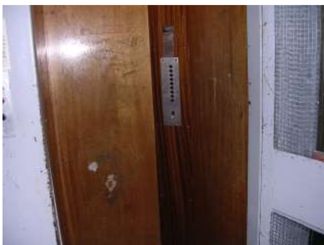
Křišťálová – dřevěná kabina
