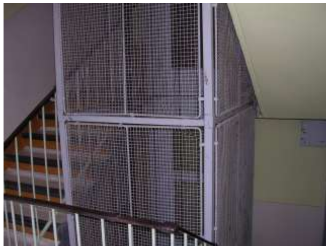
Výtah s drátěnou klecí – objekty Křišťálová
