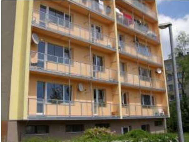
Opravené lodžie – Stavbařů 6
