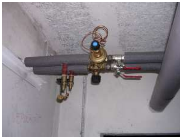
Regulátor diferenčního tlaku na stoupačce
