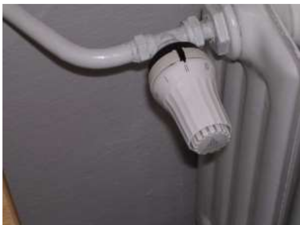
Příklady osazených termoregulačních ventilů na tělese ústředního vytápění
