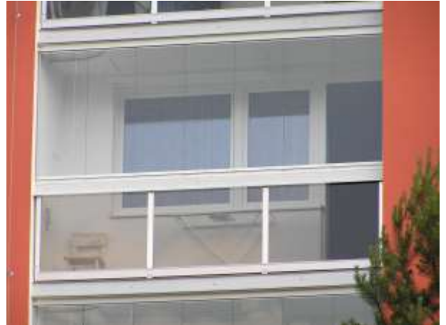
Opravené a zasklené lodžie Rabasova 6 - 12
