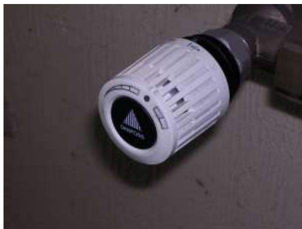
Příklady osazených termoregulačních ventilů na tělese ústředního vytápění
