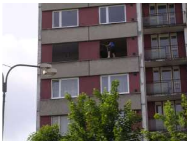
Prováděná výměna – Liberecká 45
